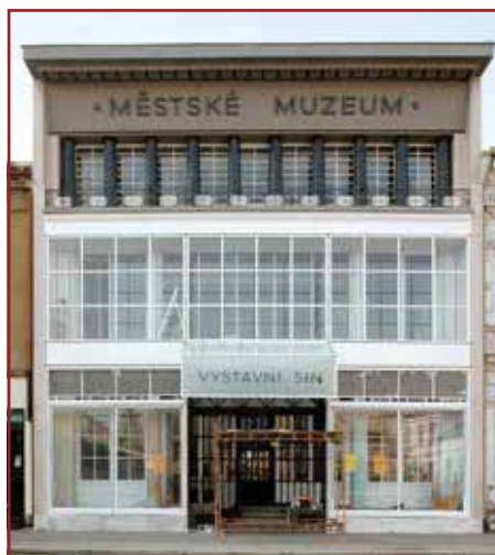
Na fasádě Wenkeova obchodního domu v Jaroměři použil Gočár předsazenou prosklenou fasádu s průběžným oknem, tedy prvky, které se staly základními znaky funkcionalismu o deset let později.
