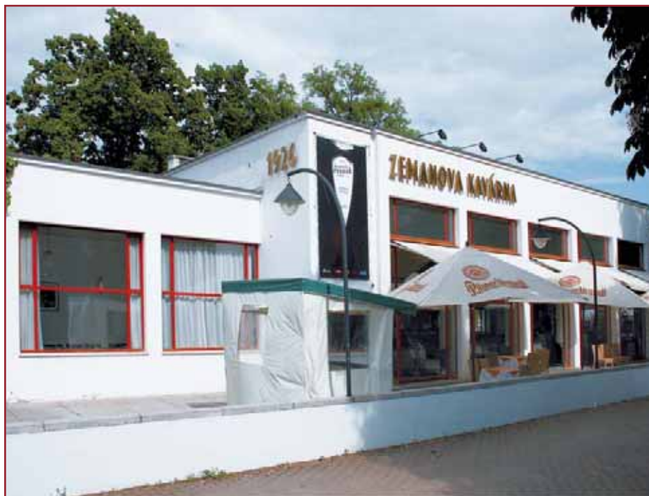
První Fuchsova ryze funkcionalistická stavba – Zemanova kavárna v Brně z let 1925–26 – byla roku 1965 zbořena a teprve o třicet let později znovu postavena podle původních plánů.
